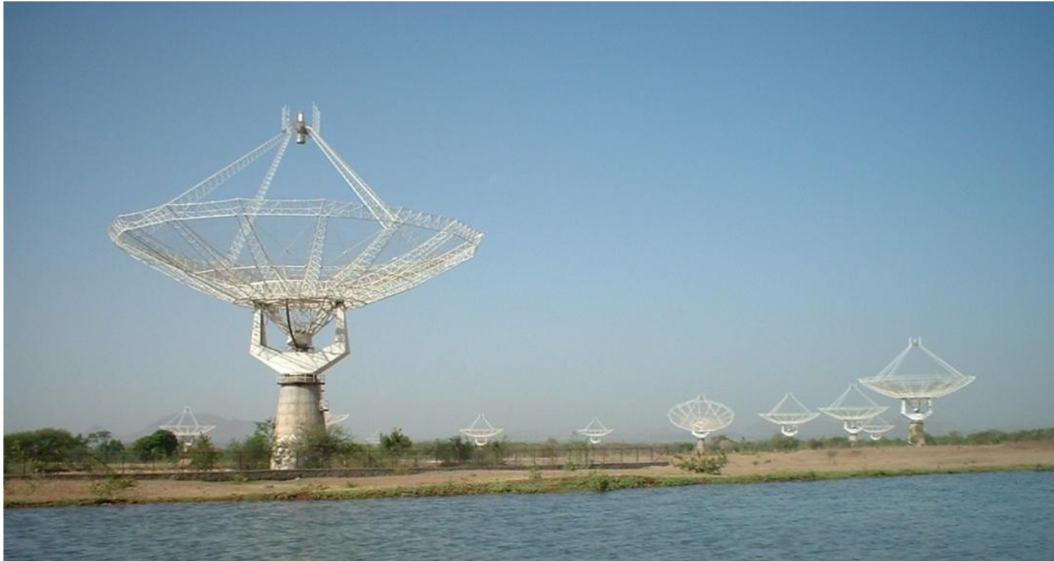
Le GMRT : 30 antennes de 45m, Khodad, Inde
